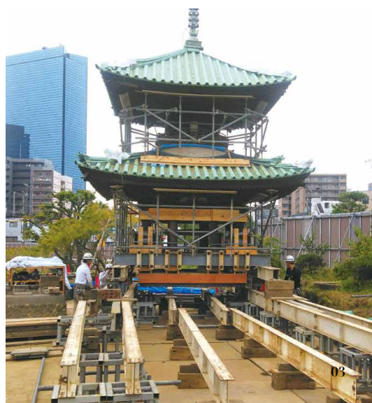
大阪・藤田美術館の多宝塔。高野山光台院に400年前に建立され、大正期に現在地に移築された。美術館の建て替えに伴い、国内の塔建築としては初めて、匠弘堂が曳家・修理を行った。
