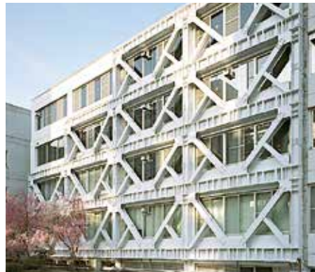
▲ハイブリッド耐震補強工法で施工した学校。外壁に施された「バテン」型の補強材は、誰しも一度は目にしたことがあるはず。
